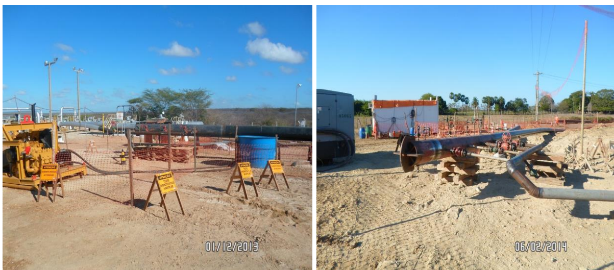
Figura 5: Teste hidrostático do oleoduto de DN 26 pol.
