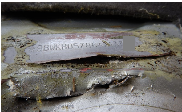
Figura 19 - Destacamento da chapa sobreposta. Fonte: Autor.
