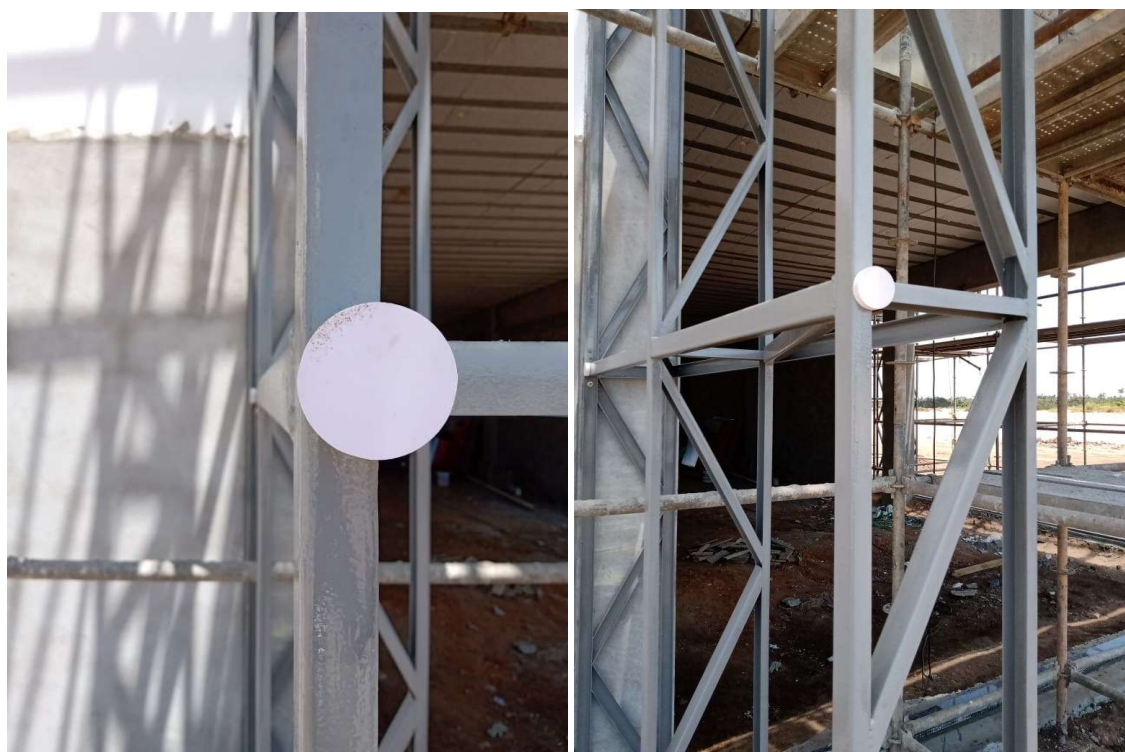
Figura 23 – Marcador fixado na estrutura.
