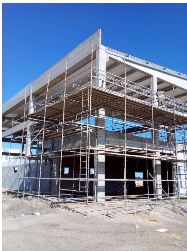
Figura 22 – Local do mapeamento da versão alfa, com a disposição de andaimes ao longo da estrutura.
