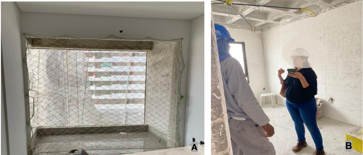
Figura 5 - Rede piso a piso instalada na varanda do empreendimento “2”. (A) Momento de entrevista com colaboradores do empreendimento “2”. (B)
