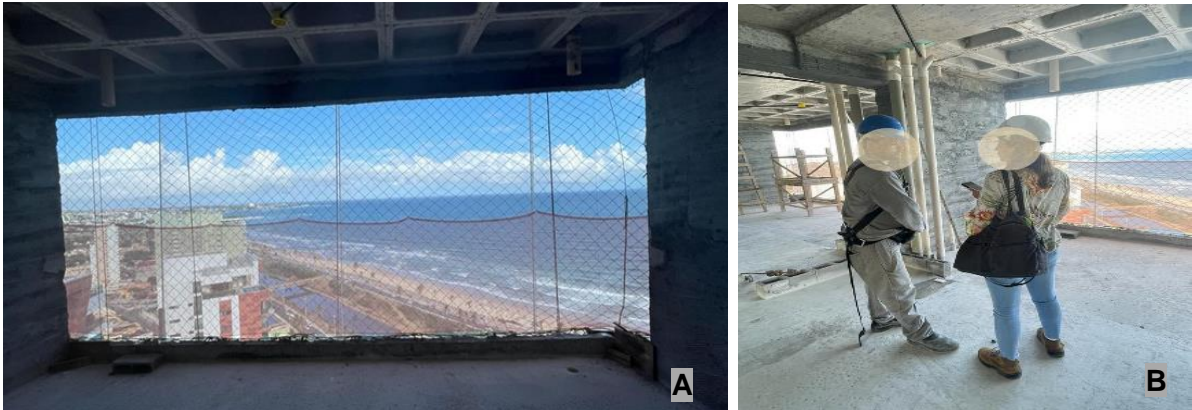
Figura 4 - Rede piso a piso instalada na fachada do empreendimento “1”. (A) Momento de entrevista com colaboradores do empreendimento “1”. (B)
