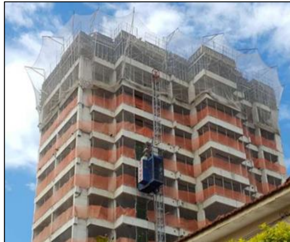
Figura 2 - Vista externa da rede piso a piso
