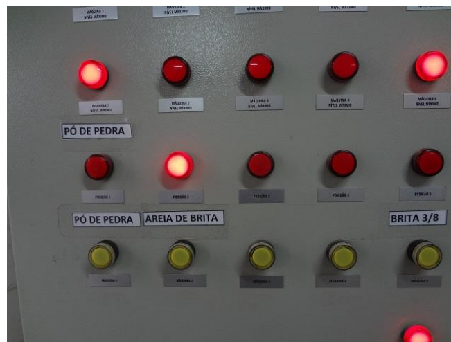
Figura 20 - Painel de Controle do processo de fabricação dos blocos
