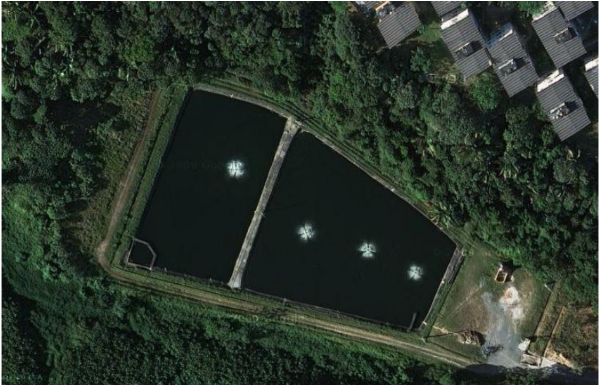
Figura 13 - Vista aérea das lagoas de estabilização da ETE Mocambo Salvador, BA
