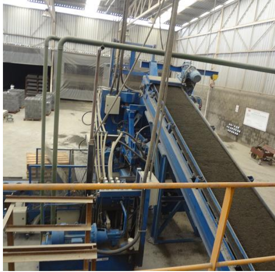
Figura 24 - Esteira para transporte do concreto para moldagem dos blocos
