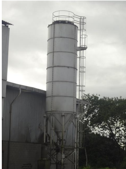
Figura 21 - Silo de estocagem do cimento
