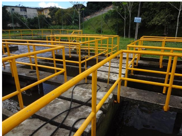
Figura 15 – Decantadores da ETE 1
